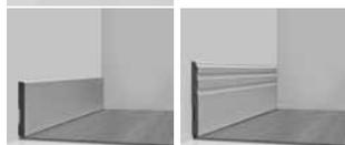
**Rodapé Composit 160 mm (Liso) e 200 mm (com Friso):** permite mais possibilidades de combinações (desenho e altura) através de sobreposições. Função de conduíte e disponível na cor branca.
