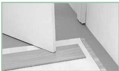
Com manta de Polietileno Eucafloor 2 mm
