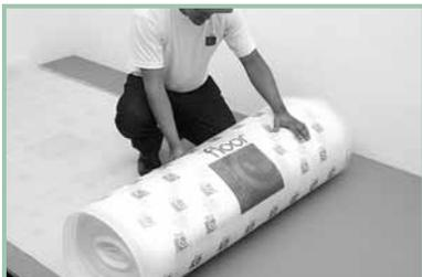
Disponha a Manta de Polietileno Eucafloor 2mm expandida com as bordas adesivadas sobrepostas, colocando-as de forma que as emendas não coincidam com as juntas longitudinais do piso laminado Eucafloor.
