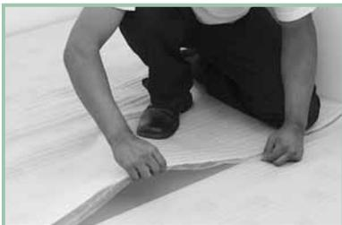
Disponha a Manta de Polietileno Eucafloor 2mm até a parede, deixando-a a meia altura do rodapé a ser instalado.
