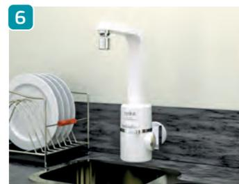
Instalação hidráulica concluída. Abrir e fechar o registro para verificar o funcionamento e conferir se possui algum vazamento.
